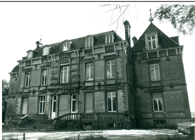
Achterzijde kasteel (foto 1977) vóór de renovatie
